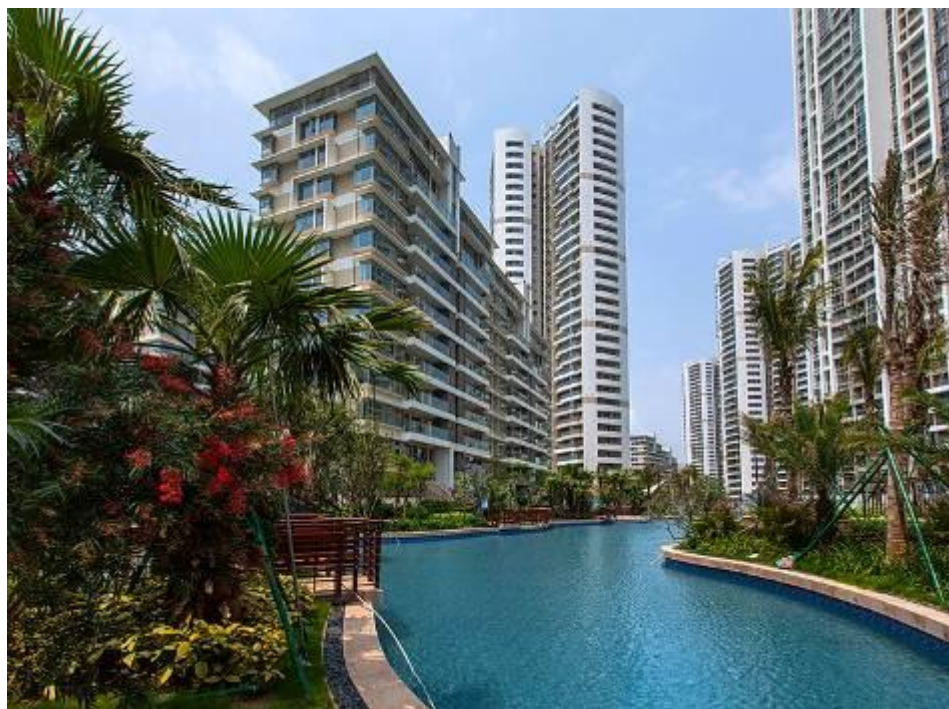
格力海岸园林沿水系铺展，形成立体多样化园林景观
