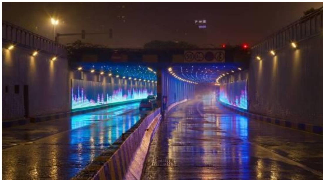
格力地产承建的地下通道美化工程，为城市添加新的亮色
